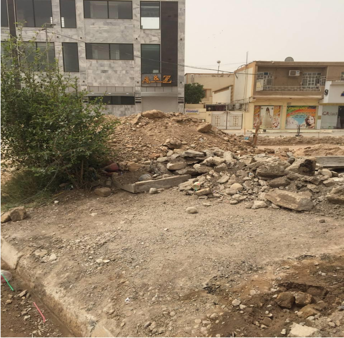
صورة (1) التاخر في اعمال البناء
